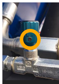
6 – Suite au réglage de la pression, procéder au blocage de la virole au moyen de la vis Allen pointe.
