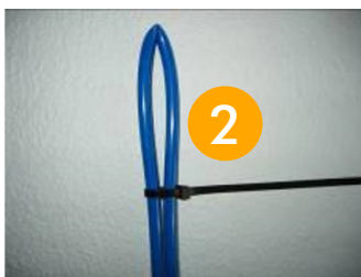
2. Anulación de tubería
